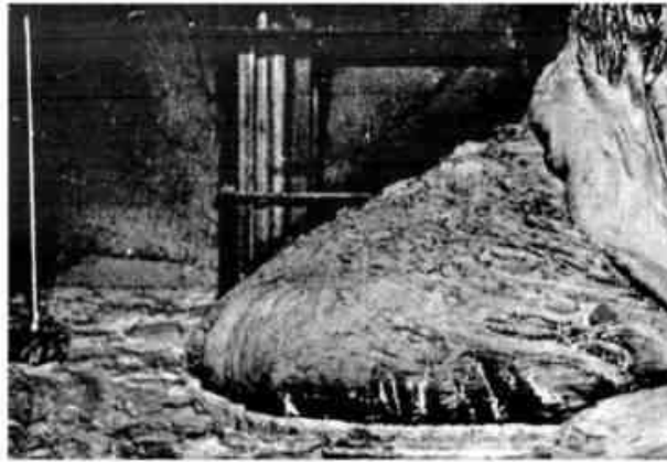
Rys. 6. Stopiony materiał rdzenia reaktora czarnobylskiego w dolnych kondygnacjach pod reaktorem. Po 32 godzinach od początku awarii strumienie lawy (corium) zaczęły stygnąć. Na powierzchni temperatura wynosiła 300°C, a wewnątrz 1600 - 1700°C 8)
