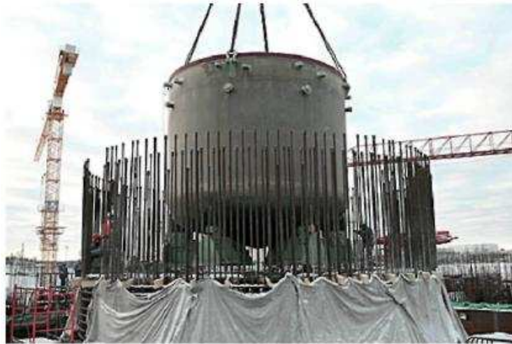
Rys. 9. Ładowanie korpusu zbiornika o masie 160 t do szybu reaktora 11)
