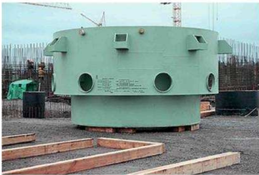
Rys. 8. Zbiornik do akumulacji corium; masa ponad 800 t 10)
